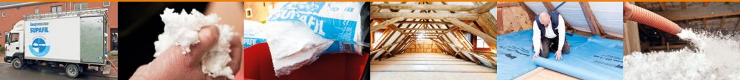
Knauf Insulation Supafil Loft Plus ist ein loser, von Natur aus nicht-brennbarer Dämmstoff, der ein wenig an Watte erinnert. Er wird über Schläuche direkt auf die Oberste Geschosdecke aufgeblasen.
