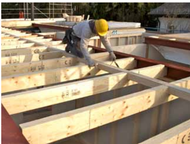
STEICO LVL R bei der Konstruktion von Deckentragwerken.
