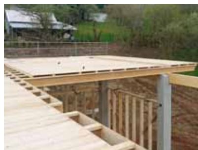
Realisierung großer Spannweiten mit den leichten STEICOjoist Tragwerken
