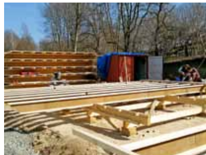
STEICOjoist Stegträger wurden zugeschnitten angeliefert und vor Ort zu Dachelementen zusammengesetzt.
