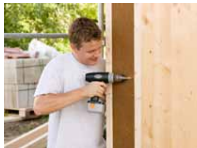
Befestigung von STEICOWall Stegträgern mittels Holzschrauben durch den hinteren Gurt.
