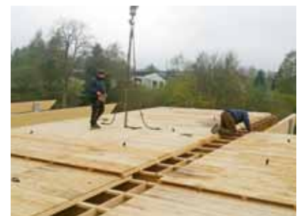
Zimmermannsmäßige Verbindung der Dachelemente über Montageöffnungen
