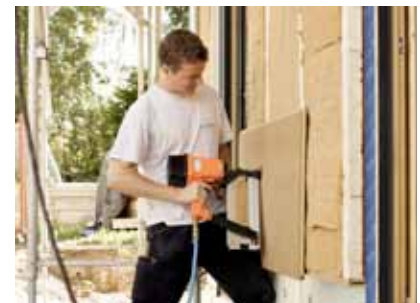
Ausdämmung der Wandgefache mit STEICOflex. Gefachabschluss mit STEICOuniversal als zweite wasserführende Schicht hinter der Lärchenholzschalung.
