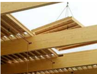
Die fertigen Elemente wurden per Kran passgenau platziert.
