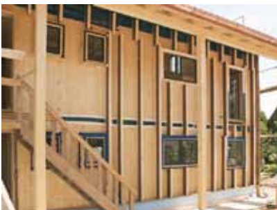
Schaffung einer Dämmebene auf der Massivholzwand durch STEICOWall als schubsteife Unterkonstruktion.
