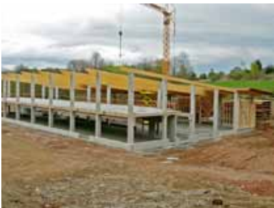
Haupttragwerk: Gabelgelagerte Brettschichtholzträger auf Stahlbetonstützen
